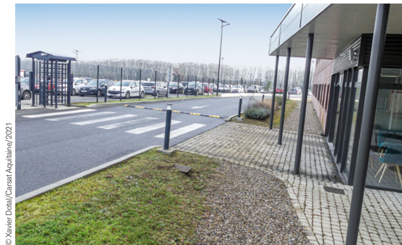
Photo 4.1 – Écarteur de circulation au droit d'un débouché de porte.
