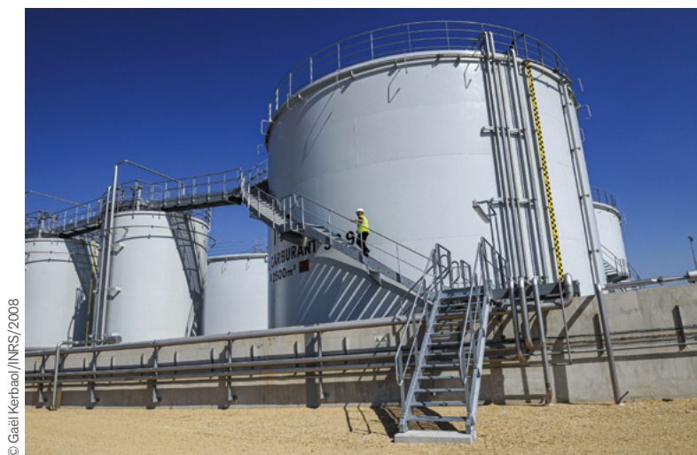
Photo 8.2 – Accès et protection collective sur un bac de stockage.
