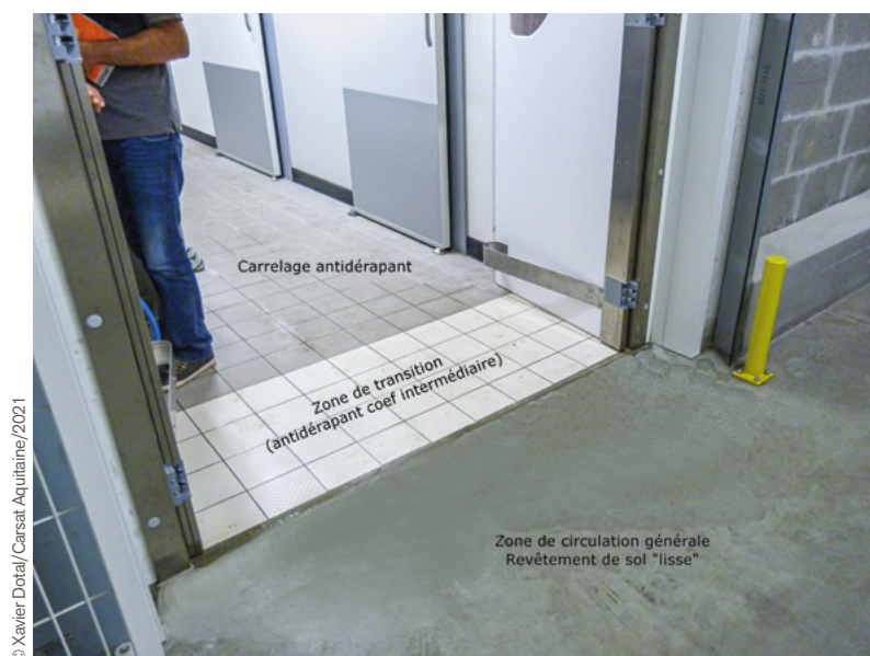
Photo 7.2 – Exemple de revêtement antidérapant avec une zone de transition de coefficient intermédiaire permettant de limiter les risques de chute.
