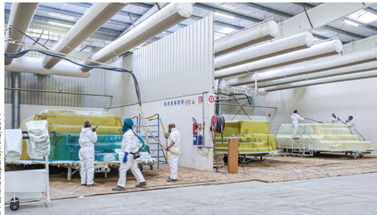
■ Photo 5.3 – Gains textiles dites « chaussettes » pour diffusion d'air à basse vitesse.
