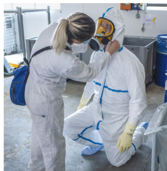
■ Figure 20. Port d'une tenue non ventilée, gants et masque complet avant d'entrer dans une zone de contamination radioactive en cours de démantèlement
