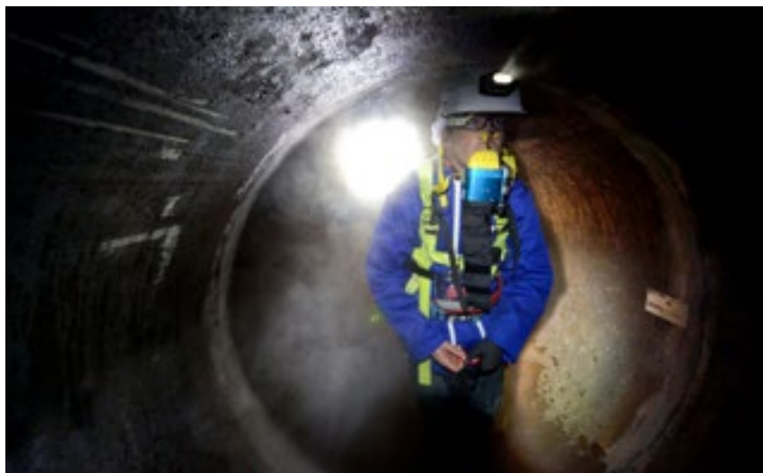
■ Photo 3 – Intervention en réseau d'eau
